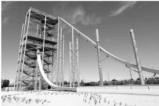
FIGURE 1 – Gauche : photographie du toboggan “le géant” du parc de WaveIsland. Pour ce toboggan, qui est le plus haut de France, h = 33 \text{ m} et \alpha \approx 45^\circ . Droite : modélisation retenue pour l'étude du toboggan.
